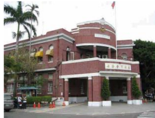
照片 32 建築物外觀經過油漆的重新塗刷
