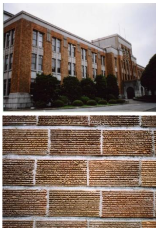
照片 10 石川縣廳舍 (大正 13 年：1924 年竣工)
