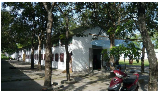
圖 8 隘寮營區安置所
