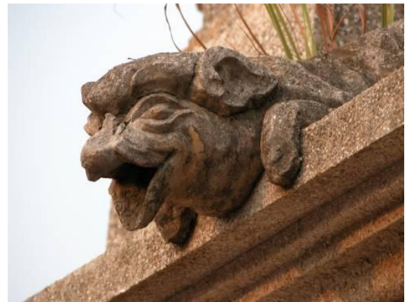
圖 35：豬造型的落水口（水頭黃廷瓢宅第護龍洋樓）
