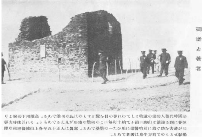
圖3-29 清治時期防番遺物(圖引自橋本白水, 1999), 應屬於第三階段望樓所殘餘之基座部分, 該部分與城門設有拱門孔道的構造不同, 基座部分幾乎完全封閉。是隔斷與封閉相當強的構造
