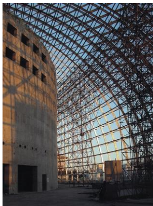
圖 7 建造中的大劇院，可見空腹網殼體鋼構的採用（Jodidio，2004:173）
