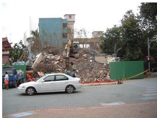
圖 13 蘭州派出所拆除過程
