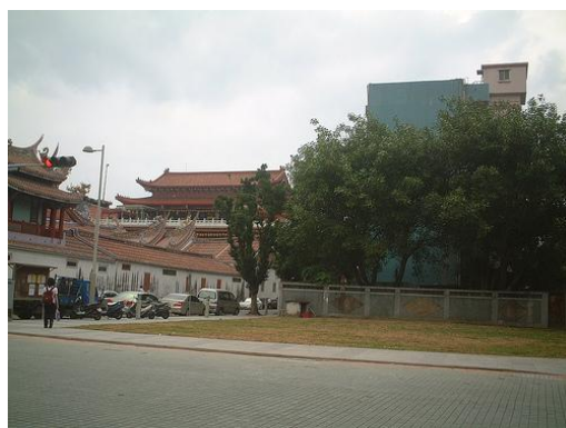
圖 14 蘭州派出所拆除後現況
