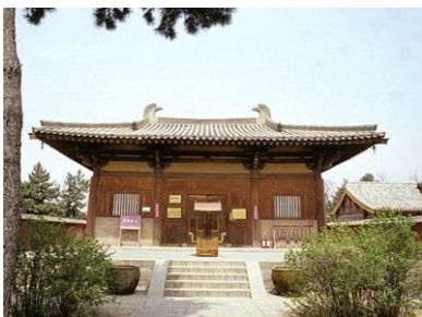
圖 5 五台山南禪寺單檐歇山式之斗拱出挑深遠(A.D.782)
