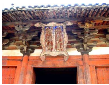
圖 6 五台山佛光寺單檐四阿式屋頂之斗拱細部(A.D.857)
