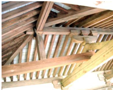
圖 8 法隆寺的複雜梁柱與斗拱複合狀況
