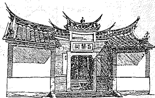
圖3-a 內埔昌黎祠入口原貌
