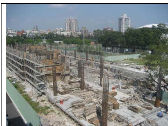
目前施工現況
